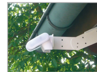
Fig. 8 Ejemplo de uso del brazo articulado: Mediante el brazo articulado, el sensor sobresale por debajo del alero. El sol puede actuar libremente sobre los sensores.
