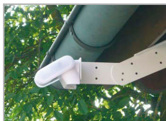
Abb. 13 Exemples d'application du bras articulé : Le bras articulé permet à la station météorologique de surplomber l'avancée du toit. Le soleil, le vent et les précipitations peuvent être interceptés sans entraves par les détecteurs.
