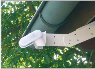
Abb. 13 Beispiel für den Einsatz eines Auslegers: Durch den Gelenk-Ausleger ragt der Sensor unter dem Dachvorsprung hervor.
